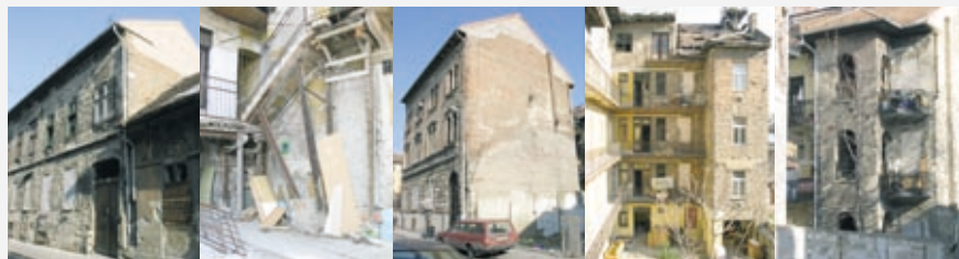
Lebontásra kerülő épületek
