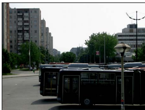
Az Etele tér környezetében álló épületek nem „magasházak”
