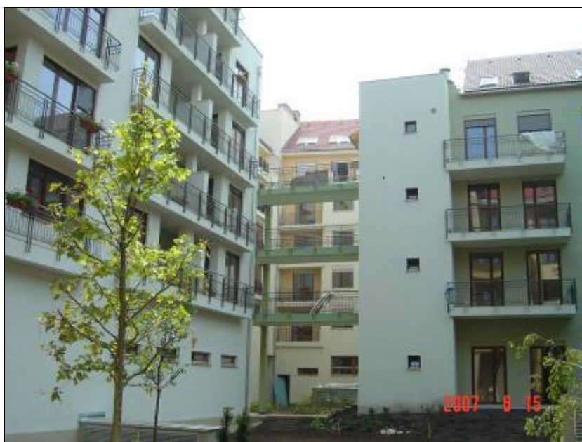
7. kép: Budapesti 88 lakásos társasház homlokzatai
