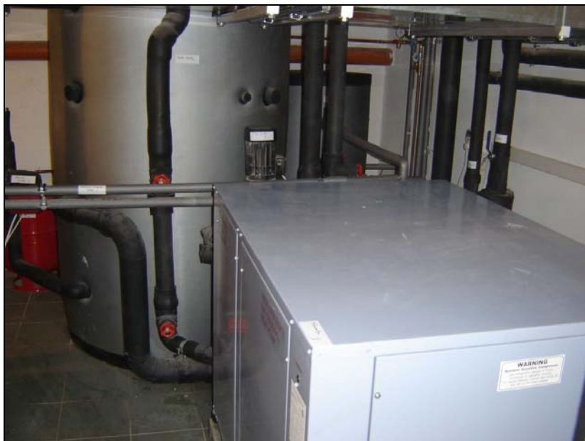
6. kép: ATIKÖFE szegedi irodaház hőszivattyús hőközpontja
