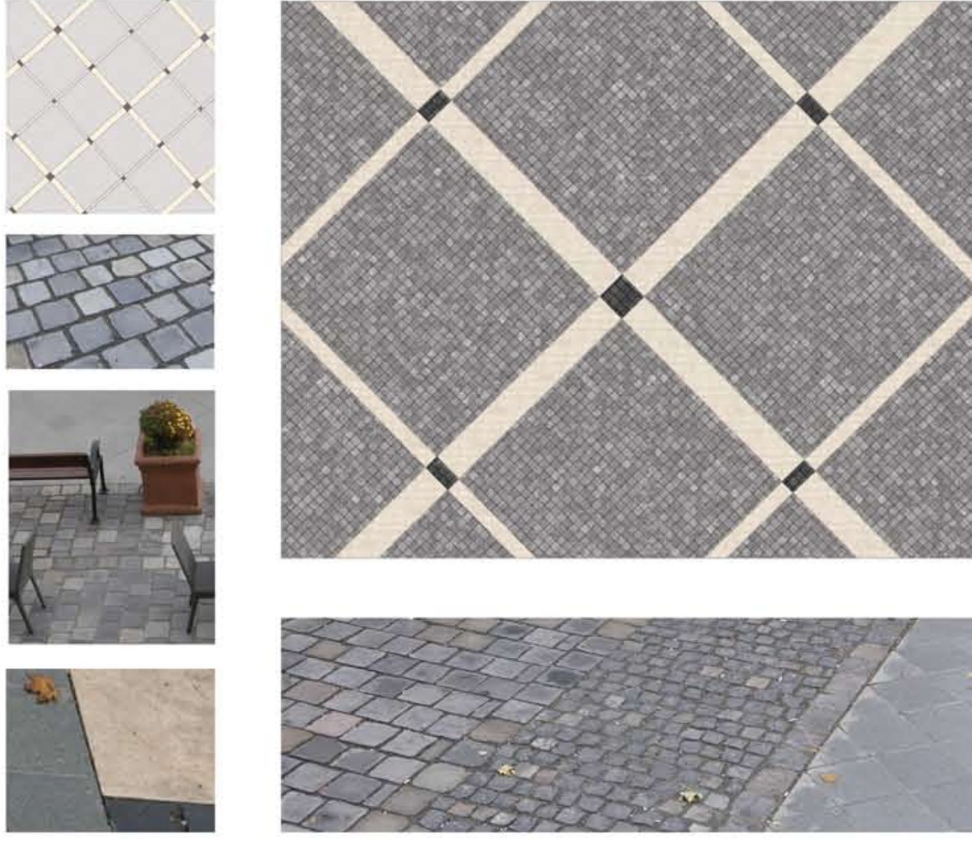
A Fő tér belső része fűrészelt andezit lapokkal burkolt, míg a gyalogos közlekedésre kijelölt sávok fűrészelt nagykockakő felülettel, kiskockakő raszterrel épülnek.
