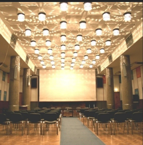
MEGLÉVŐ VETÍTŐTEREM UTÓLAG BEÉPÍTETT KÖZBENSŐ FÖDÉMMEL
