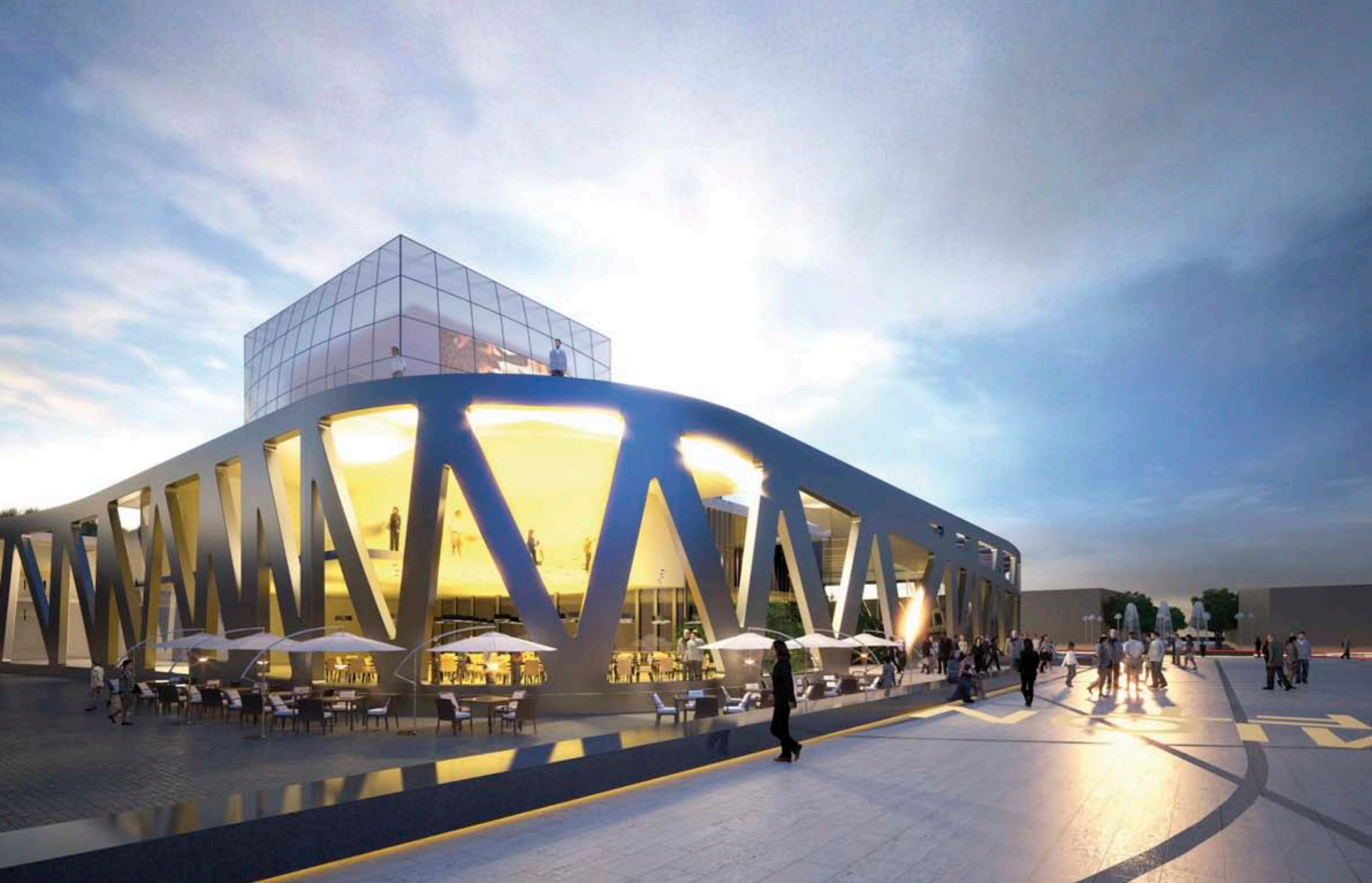
14. A WEÖRES SÁNDOR SZÍNHÁZ ÚJ ÉPÜLETE A SPORTHÁZ FELŐL
