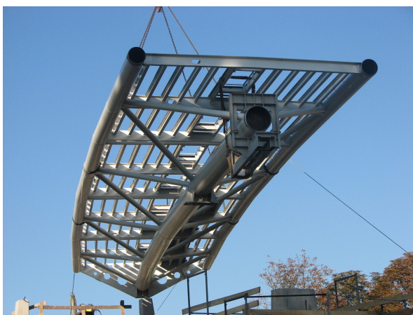
Merevítőtartó szélő elem beemelése
