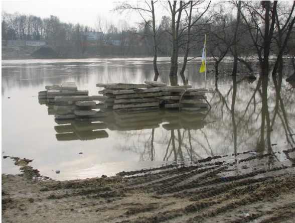
Árvíz akadályozza a pilléropítést
