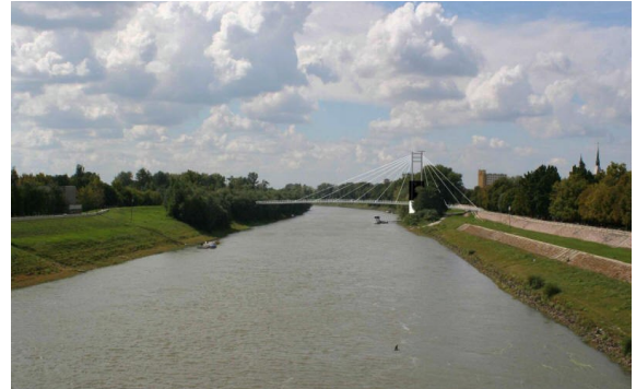
Ferde-kábeles híd (SPECIÁLTERV)
