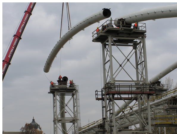
Főtartó ív zárótag beemelése
