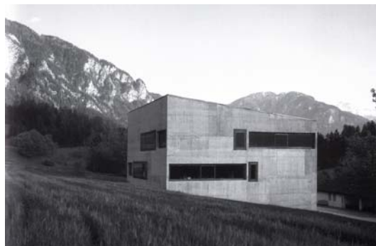
Általános iskola, Paspels építész: Valerio Olgiati, Zürich
