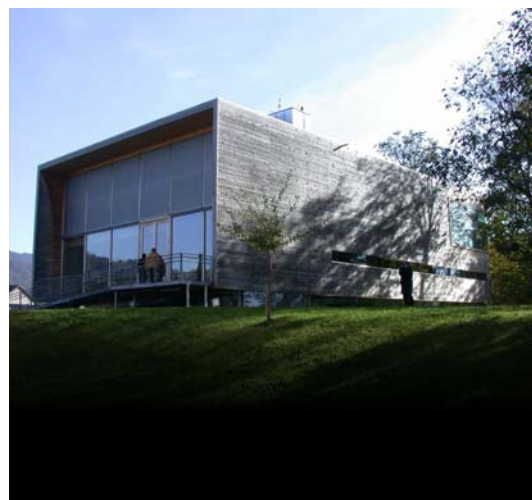
Tűzoltóság és kulturális épület, Hittisau építész: Cukrowicz Nachbaur Architekten, Bregenz
