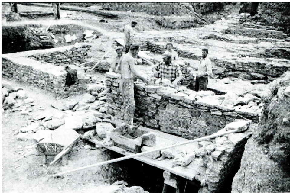
19. ábra. A pronaosz alapfalainak kiegészítése (Sz. T. felvétele)
