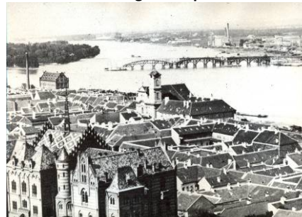
7.-18. ábra: A Margit-híd építése
