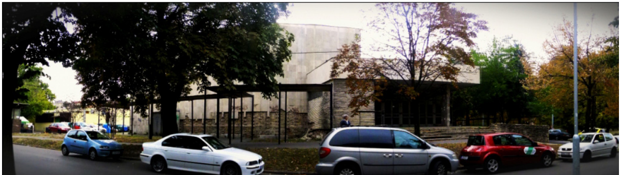
a mozi oldalhomlokzata
