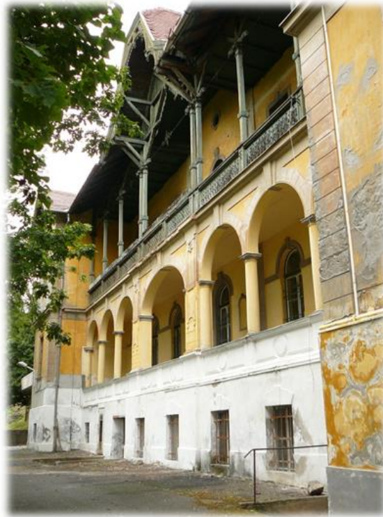
9. ábra Rehabilitációs osztály park felőli homlokzata forrás: saját készítésű kép
