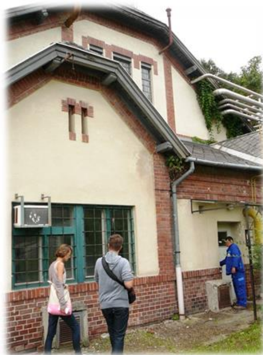
11. ábra Hőközpont ÉK-i homlokzata forrás: saját készítésű kép
