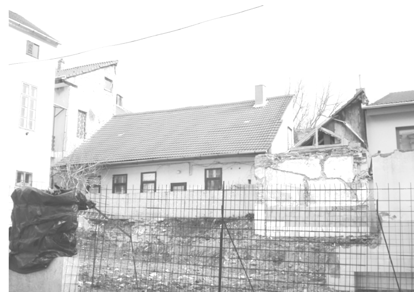
lakóépület a keleti oldalon
