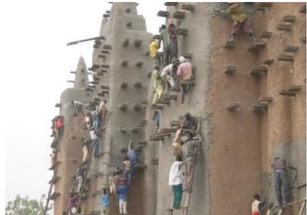
6. ábra A facölöpök állandó állványzatként szolgálnak
