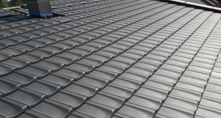
TONDACH® Tetőfedő Rangadó 2015
