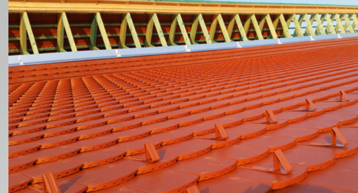
TONDACH® Tetőfedő Rangadó 2015
