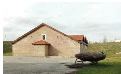
59. ábra: A lőporraktár épülete
