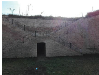
66. ábra: A felújított lépcső
