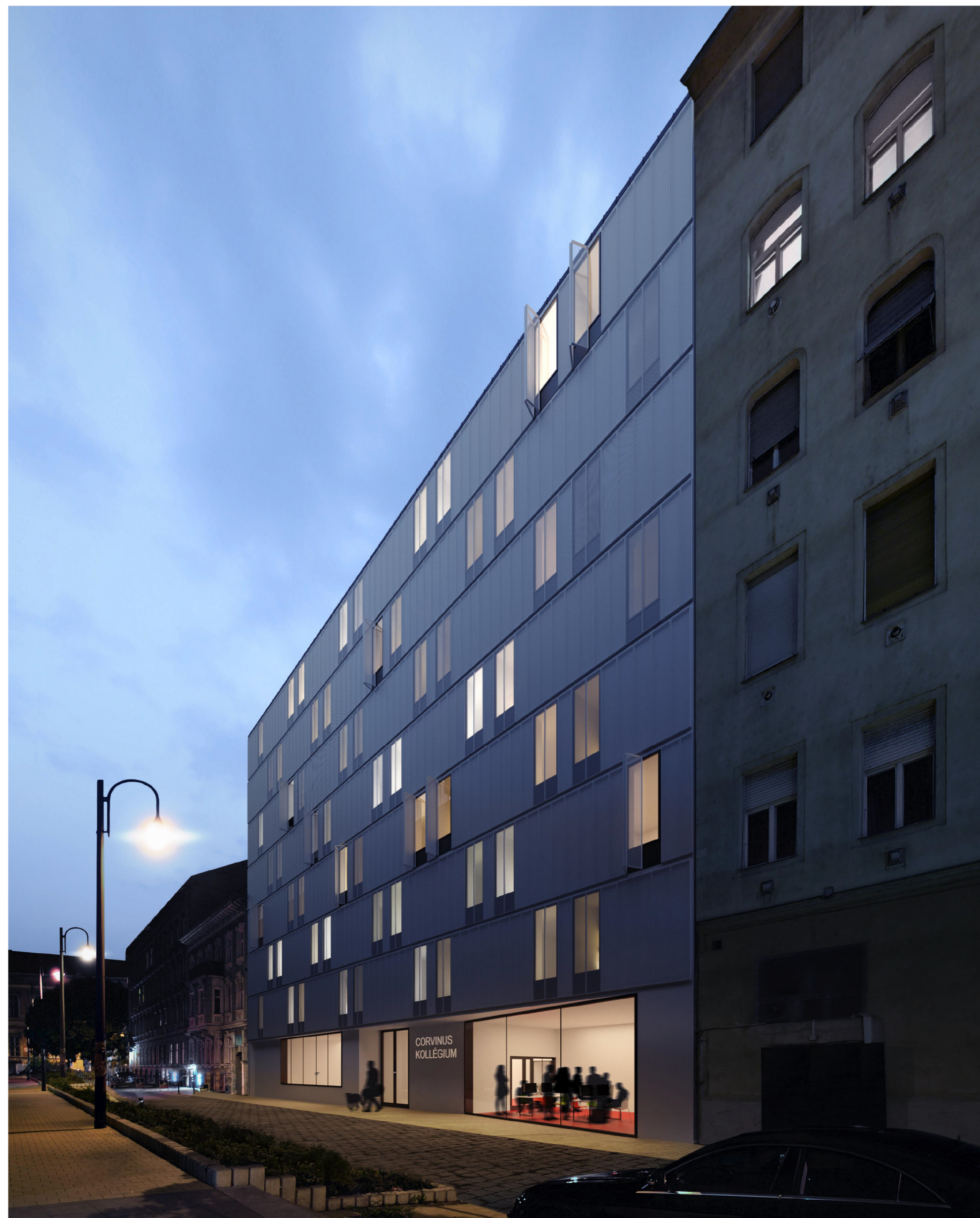
A CZUCZOR UTCAI PERFORÁLT LEMEZ HOMLOKZATON ÁTSZŰRŐDŐ FÉNYEK
