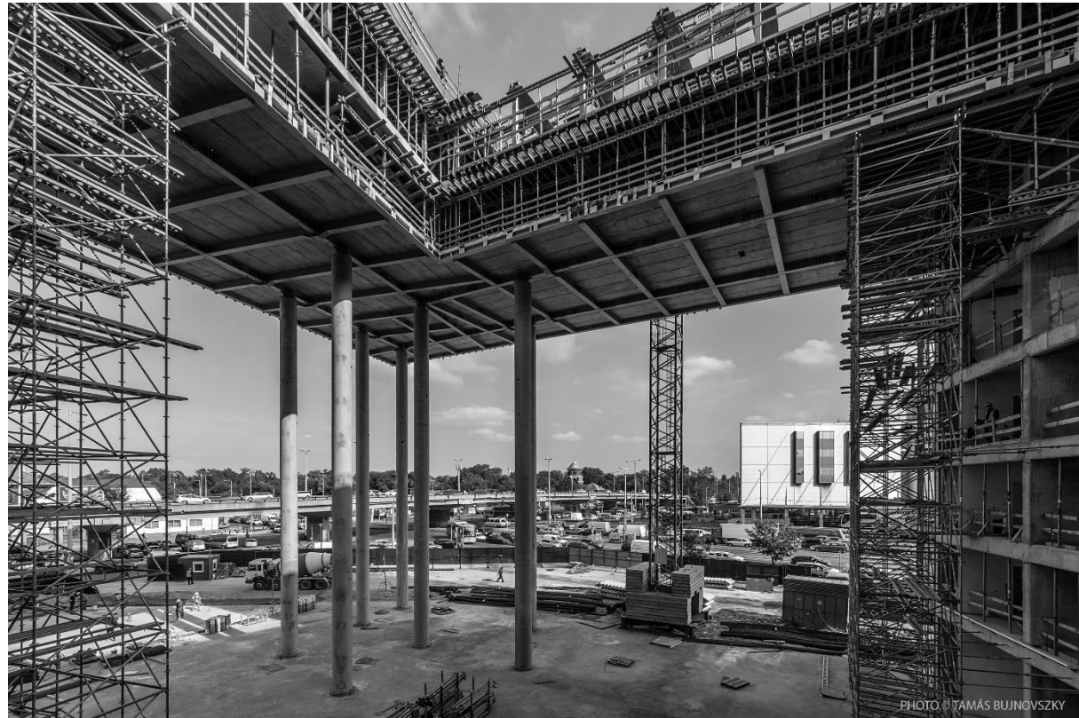
Az árkád hídszerkezet építés közben
