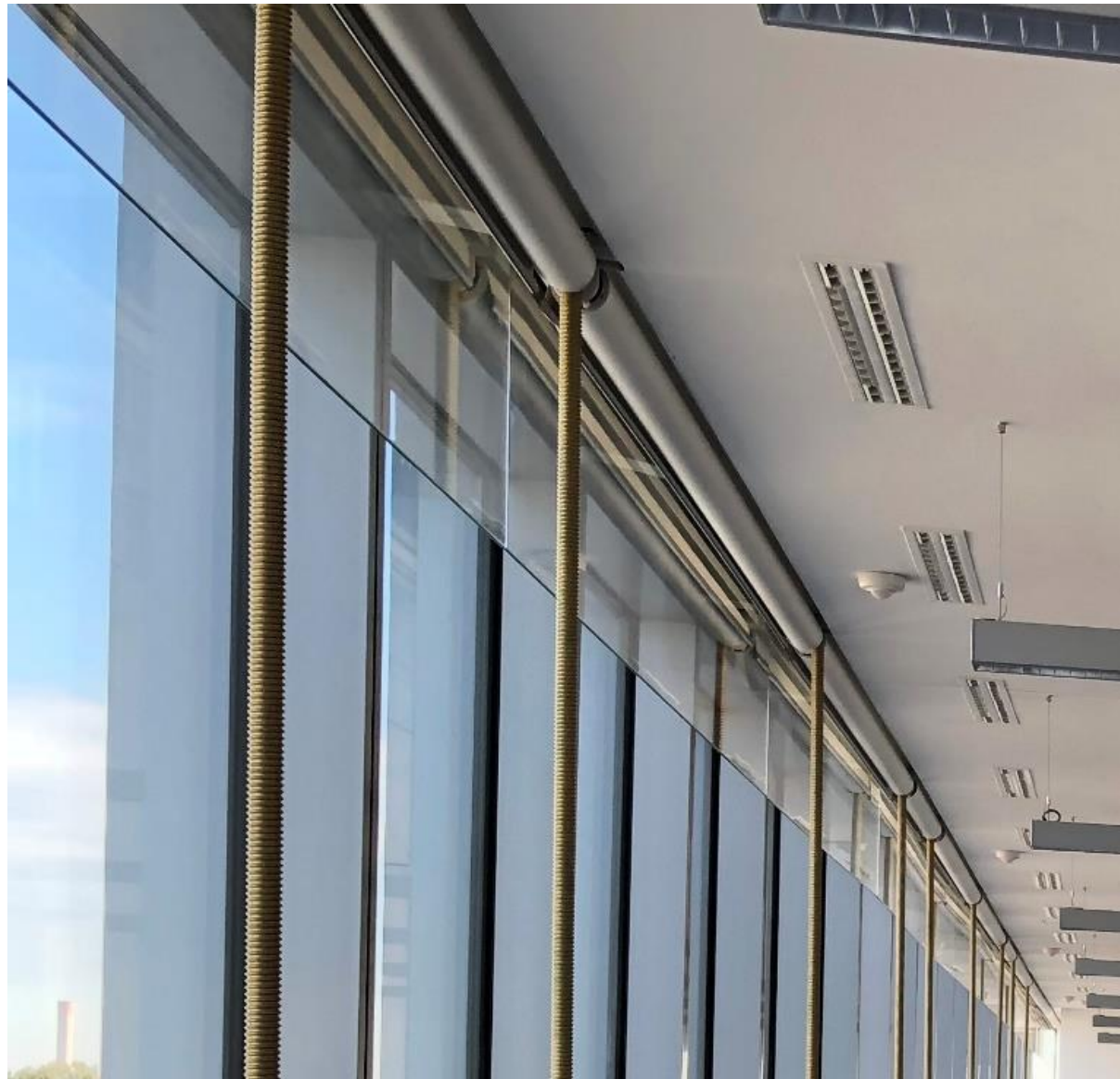
Homlokzati tűzterjedési gát egyedi minősített üvegszerkezete a „híd” irodaterületén az arany színű függesztő rudakkal, amelyek a földémszélek alakváltozásának korlátozását szolgálják.
