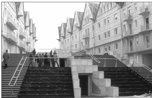
Dijon (Franciaország), új beépítés a történelmi belváros szomszédságában
