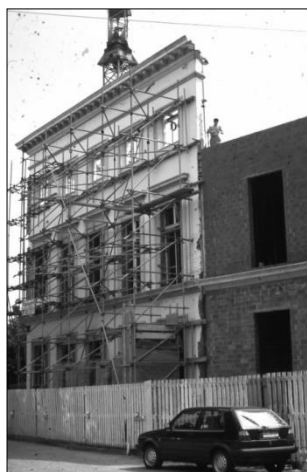
Brüsszel, új modern irodaház építése a korábban ott állt hagyományos épület homlokzatának megtartásával (Fotók: T.Z.)
