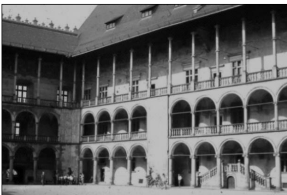
A Wawel zárt, háromszintes udvara átépítése után (1556-1560) (T.Z.)
