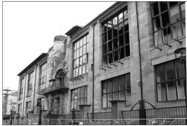
Macintosh: Glasgow, School of Art, 1897-1909 északi homlokzat (Fotók: T.Z.)
