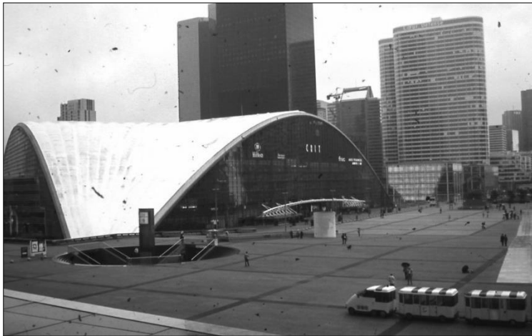
Párizs, La Défense, előtérben a CNIT 238 m fesztávú csarnoka még 1958-ból (T.Z.)
