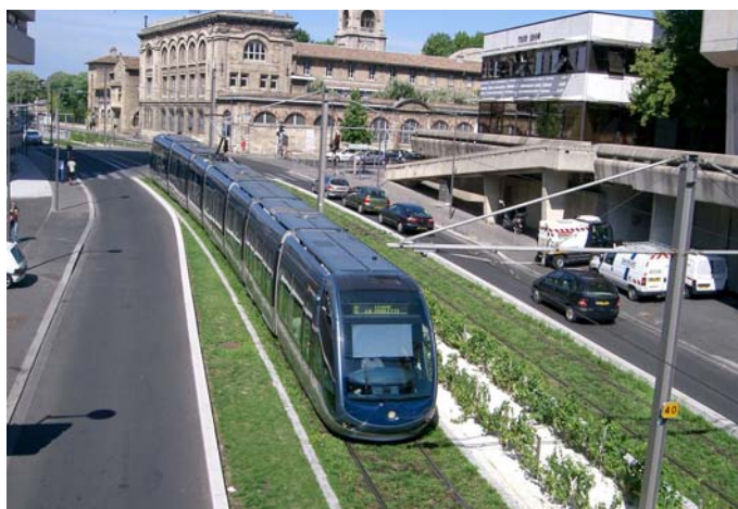
Sugárút Bordeaux-ban füvesített villamospályával. A közúti felület csökkentése lélegzethez juttatta a várost
