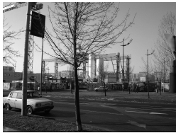
épülő 4-es metró végállomás
