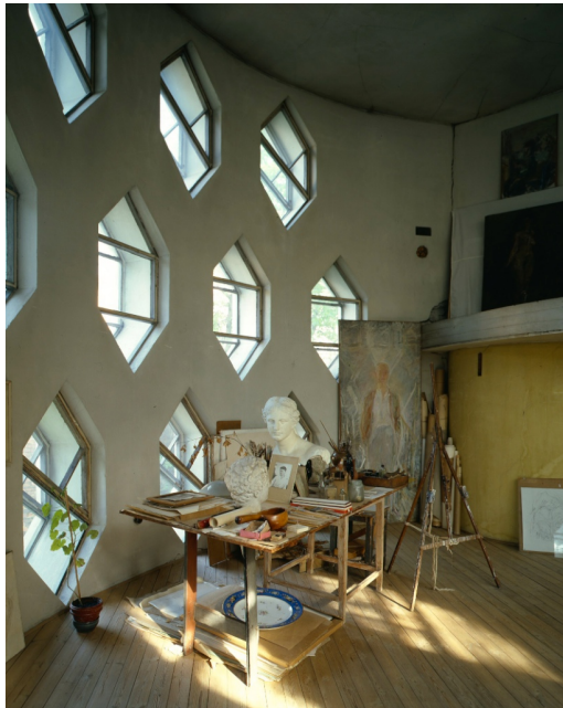
Fényszövés: egyedi hatszögű ablakokkal megvilágított műterem, Konstantin Melnikov moszkvai házában (1927), A méhsejt rács téglafalban lett kialakítva.
