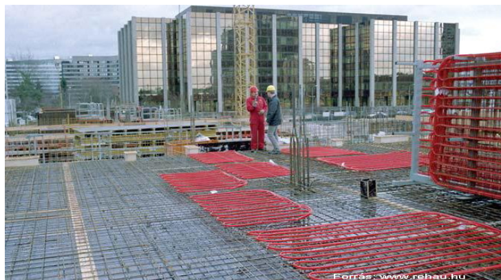
Szerkezettemperálás kivitelezése
