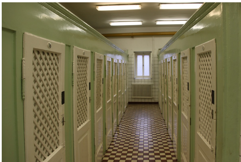
12) Meglévő emeleti öltözőkabinok
