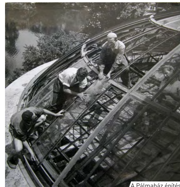
A Pálmaház építése
