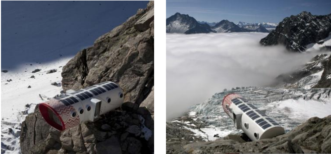
Gervasutti menedékház: LEAPfactory építésziroda, Mt. Blanc
