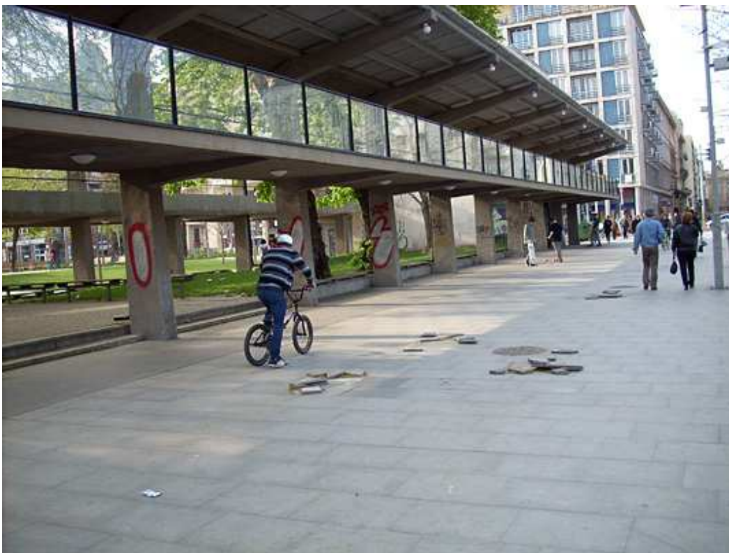
2. kép: Gödör Klub , leromlott állapot, fotó: Körte, forrás: http://criticalmass.hu/node/8811 , 2009. április 30.
