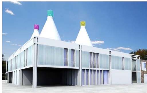
átalakított strandfogadó épület
