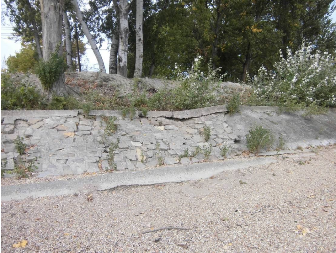
I. szakasz - Meglévő betonba rakott terméskőburkolat
