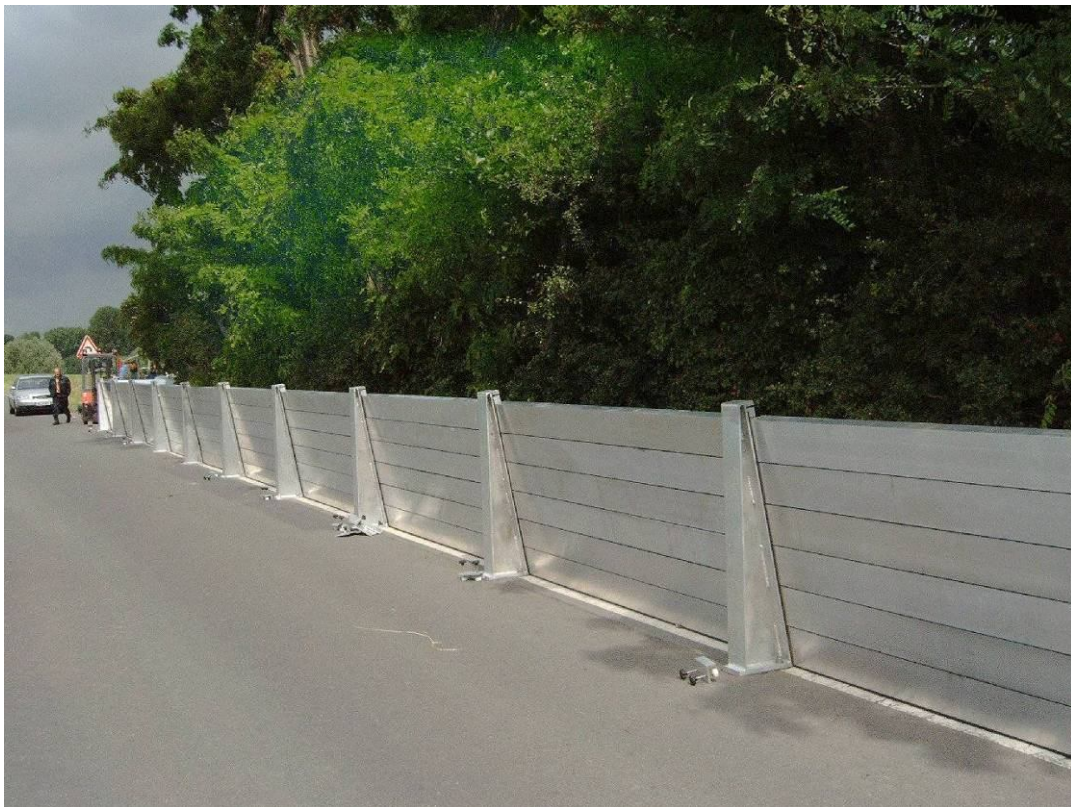
4. kép: Oszlopok közötti, betételemsé, fémszerkezetű mobilgát - összeszerelve
