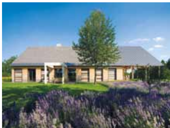
Az „Év háza” díjat Dévényi Tamás kapta sóskúti lakóházáért
