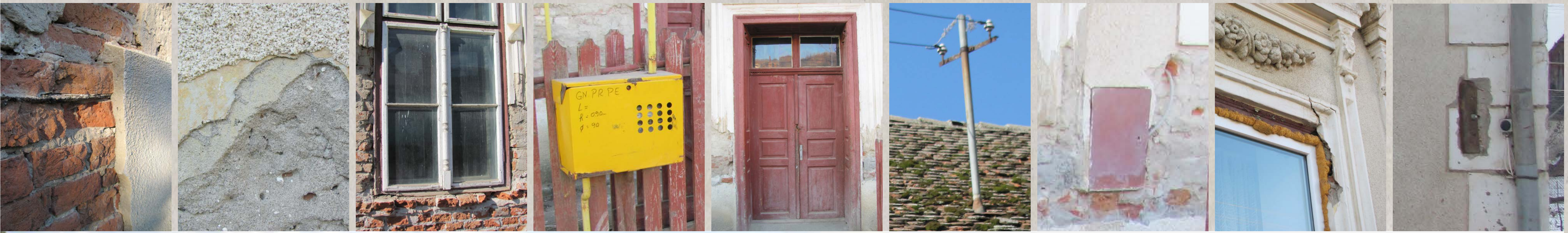
3 cm vastag lábazati vakolat külső fal vakolatrétegei régi ablak külső kifelé nyíló szárnyai gáz bekövezetése meglévő bejárati ajtó elektromos áram bekötővezetéke elektromos kapcsolódoboz új beépítési hőszigetelt műanyagablak keleti házsarok megerősítése a nyugati falhoz
