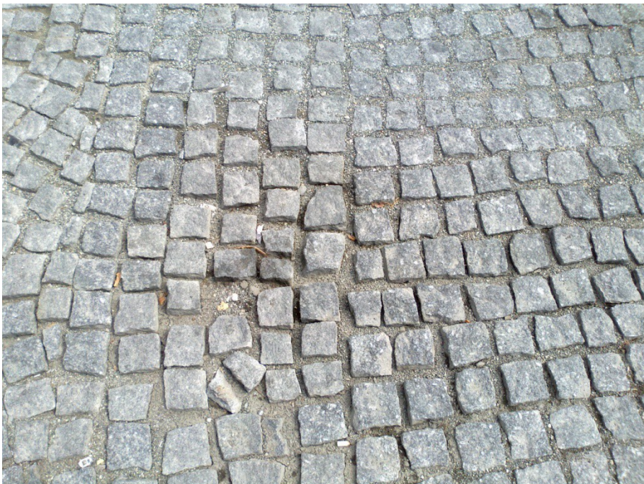
25. kép: kiskő burkolat alaktalan kiskövekből, nagyon változó hézaggal.
