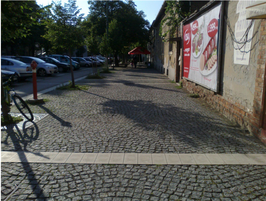
24. kép: A Szent Ferenc utcai járda és kerékpárút. A járda a kisköves! Emiatt az emberek ezt nem használják, rámennek az aszfaltos kerékpáros felületre, ott zavart okozva.
