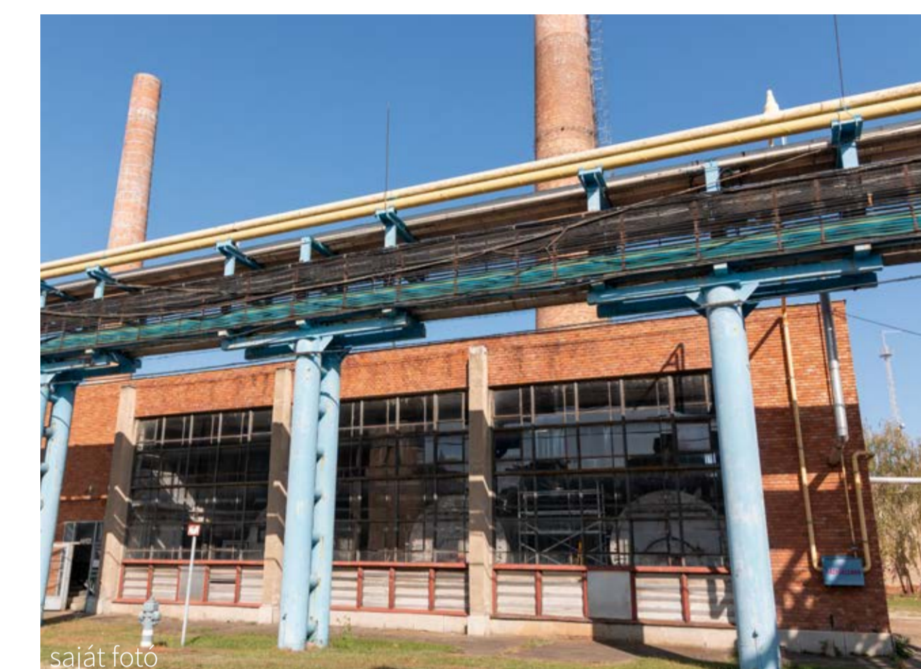
3 / HO kazán épület 1968
