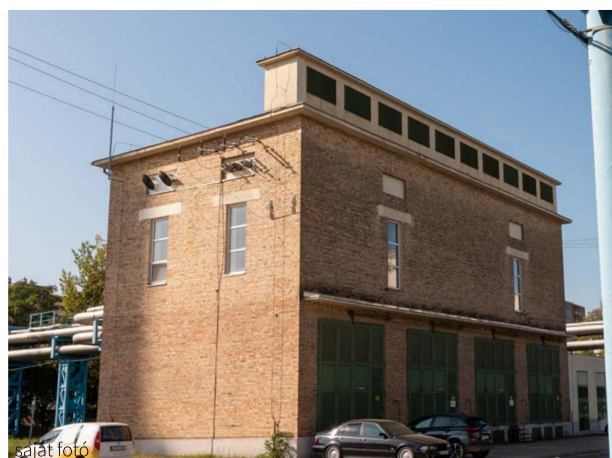
4 / elektromos művek trafóház 1956
