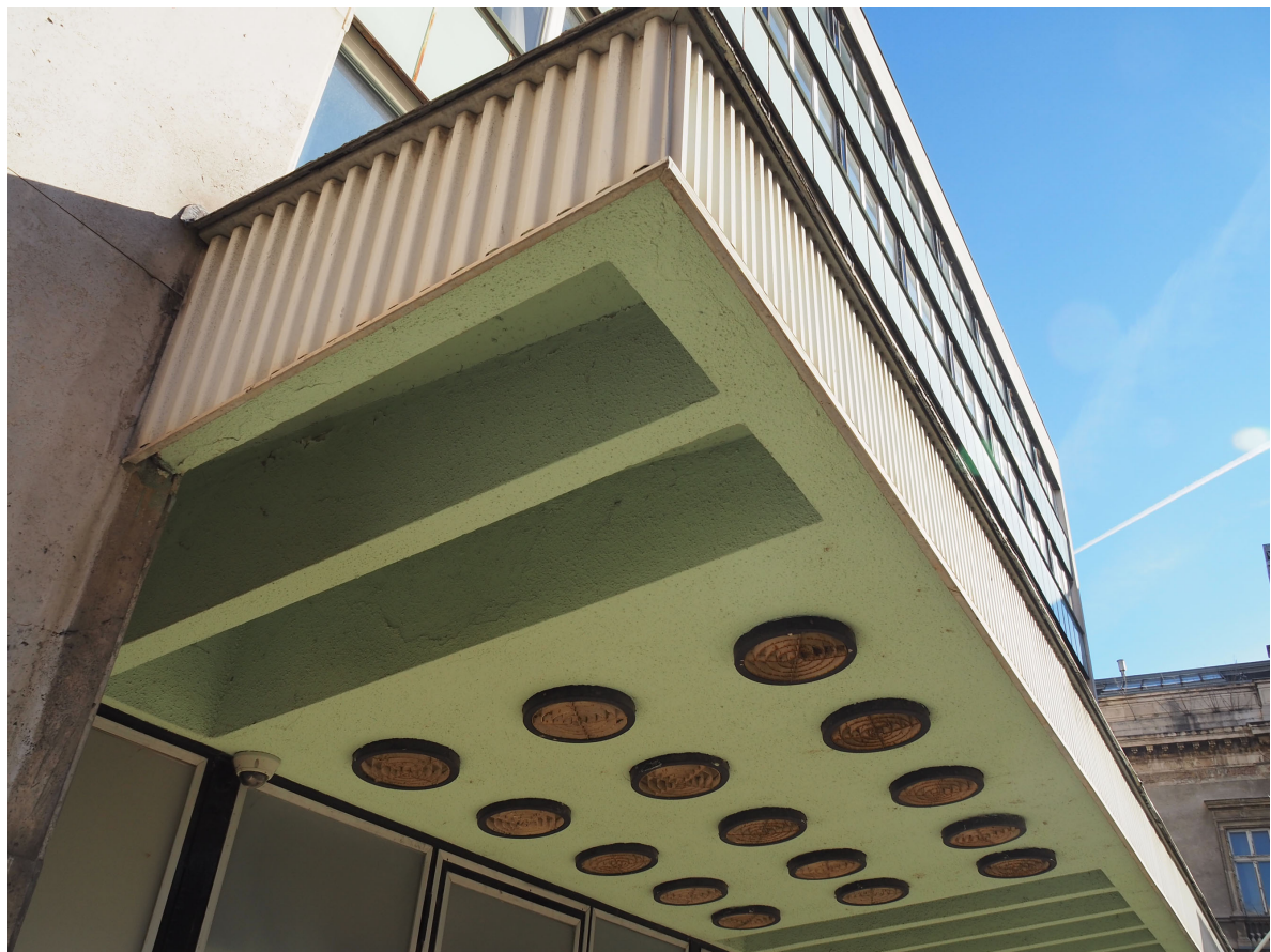
H5. Vasbeton előtető a bejárat felett
