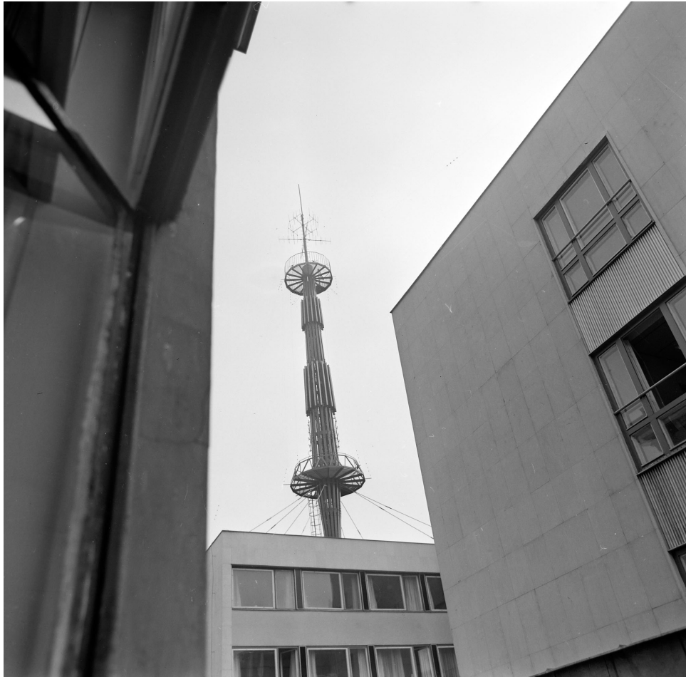
A6. Az antennatorony a keleti szárnyon, előtérben a nyugati szárny részlete, 1970 Fortepan/Szalay Zoltán, képszám: 146730
