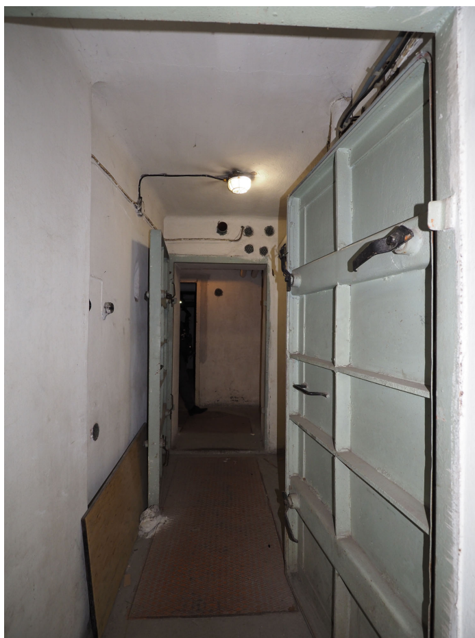
H40. Közlekedő a bunkerben
