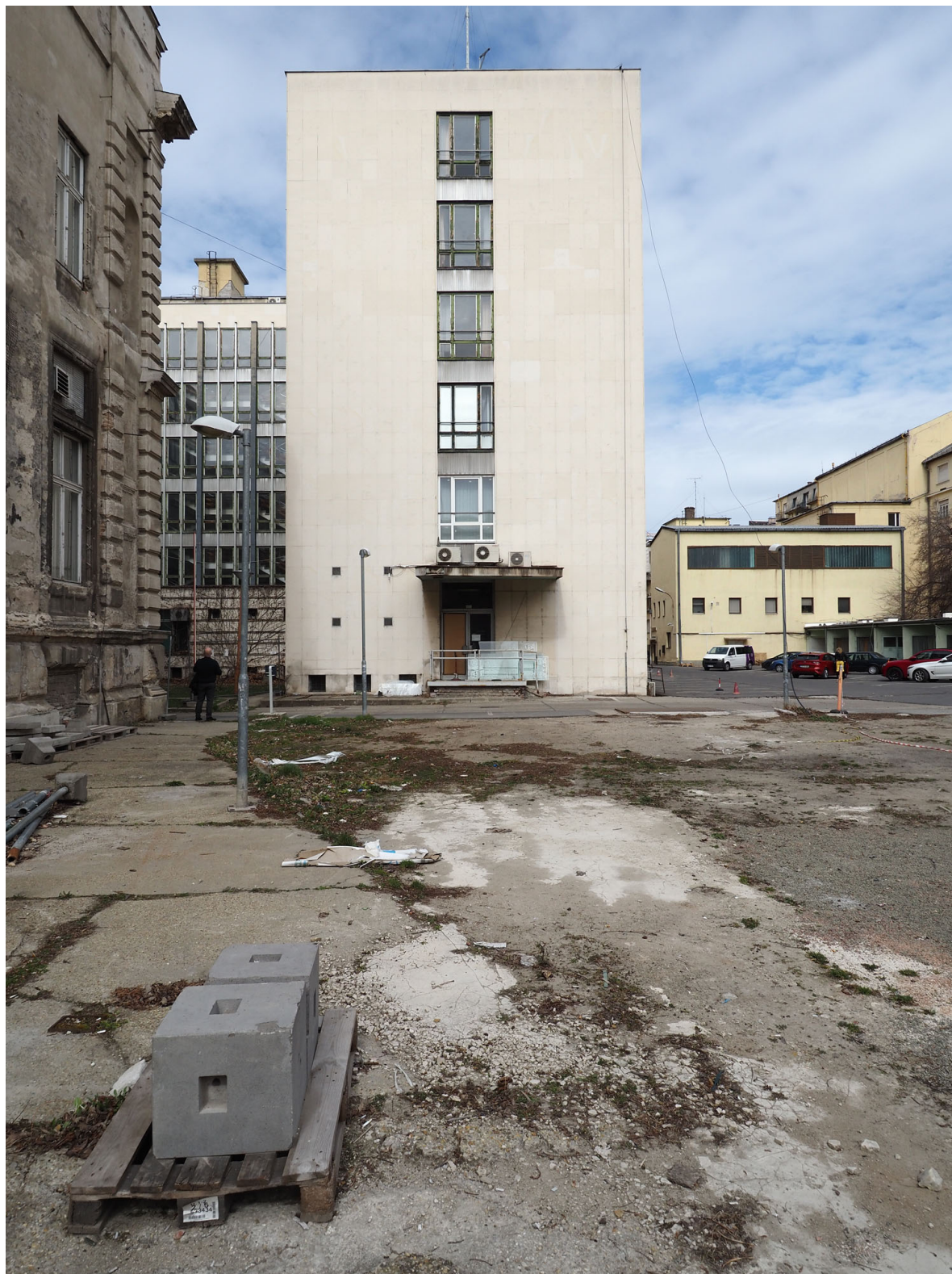
H12. A keleti szárny déli oldalhomlokzata
