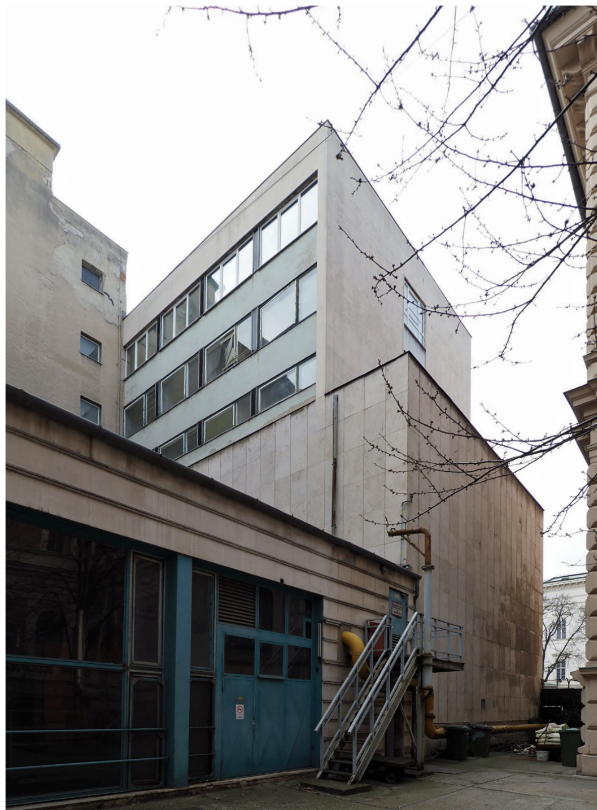
H8. A nyugati (Pollack Mihály téri) szárny keleti homlokzatának északi része és a befoglalt betonbunker hátsó oldala
