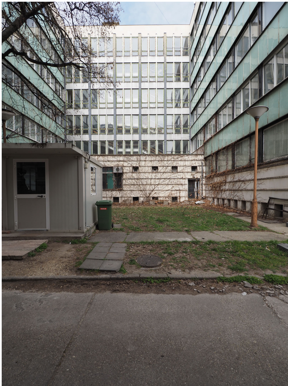
H6. A lépcsőházat magában foglaló összekötő szárny déli homlokzata
