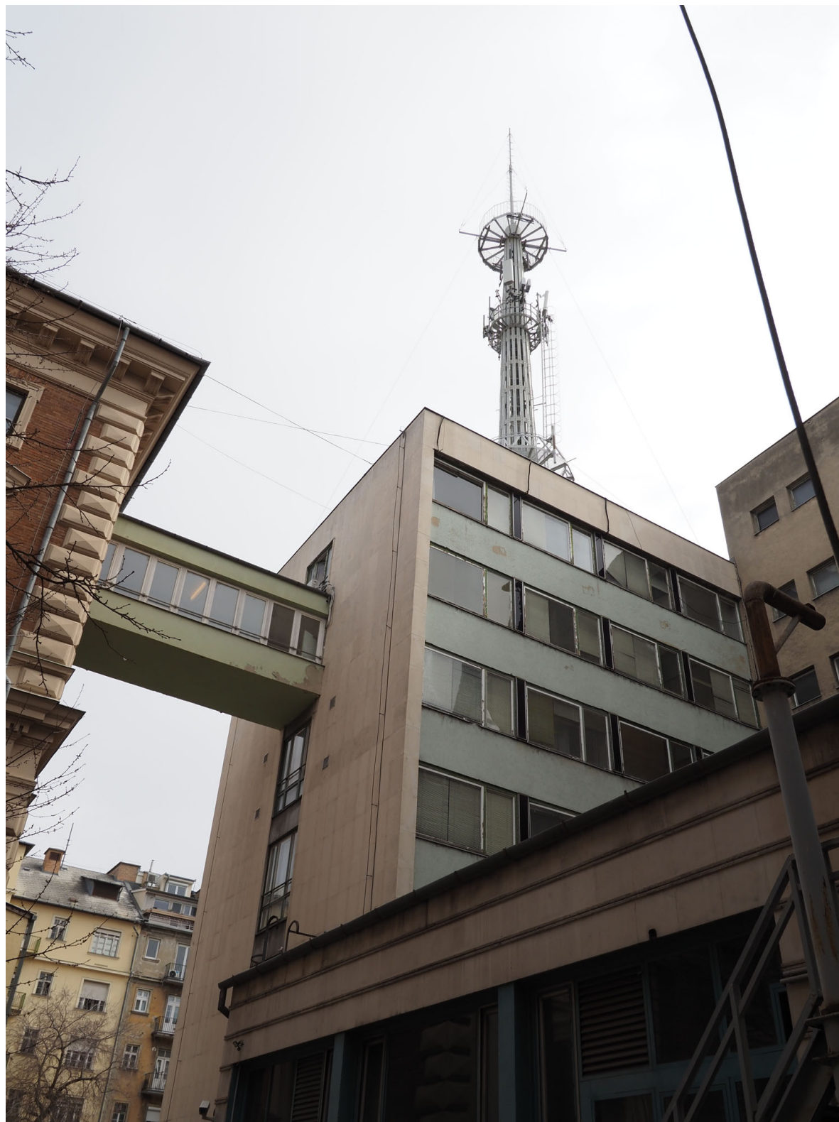
H9. A keleti szárny nyugati homlokzatának északi része, a Károlyi-palotába vezető összekötő híddal és az antennatoronnyal
