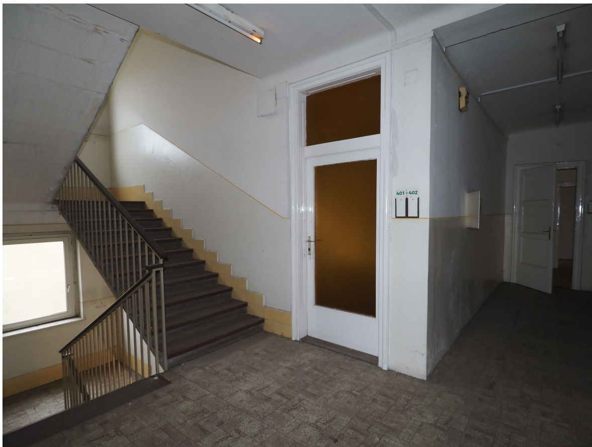
H16. Közlekedő a IV. emeleten és az V. emeletre induló lépcsőkar
