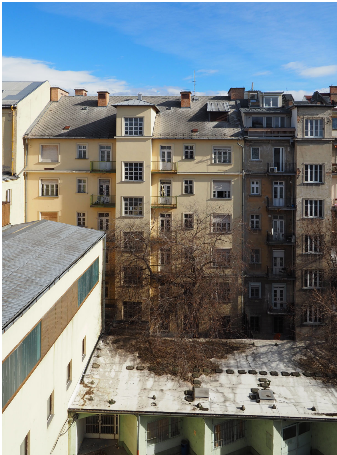
H6. Az udvari homlokzat
