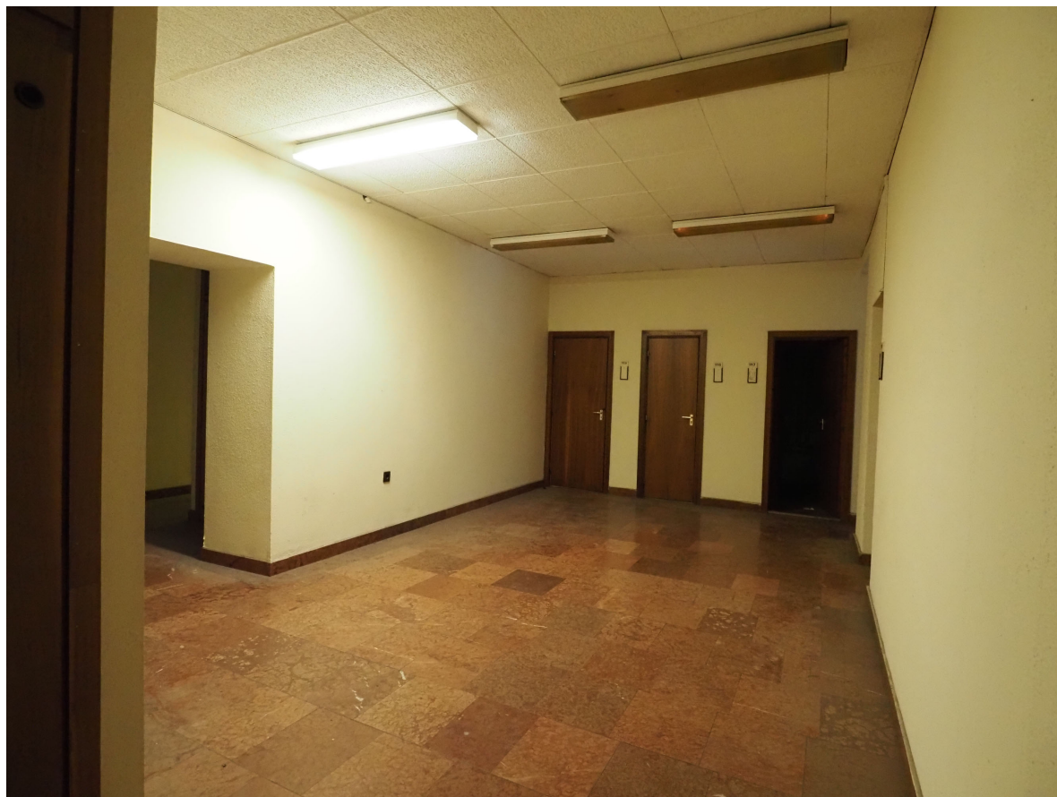
H8. Közlekedő az I. emeleten észak felé
