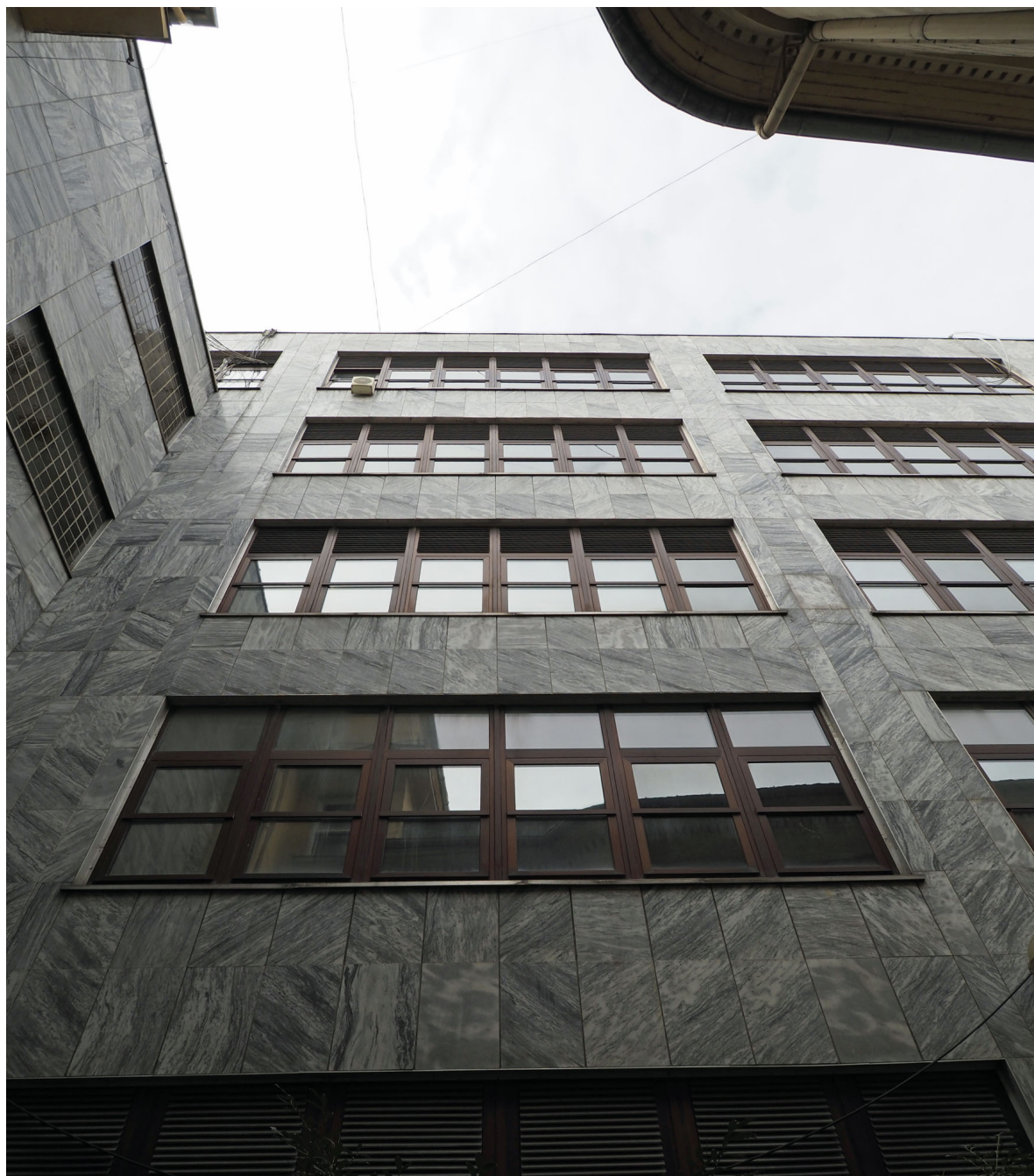
H6. A keleti homlokzat részlete
