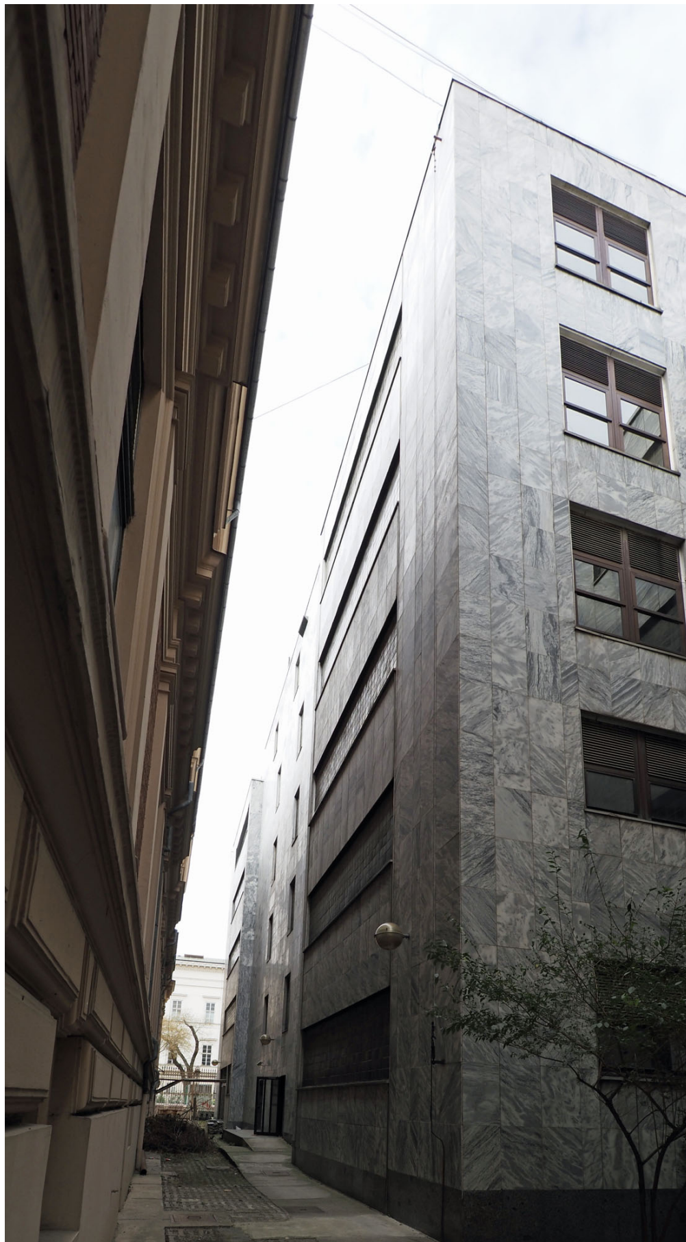
H7. Az épület a délkeleti sarkától nézve
