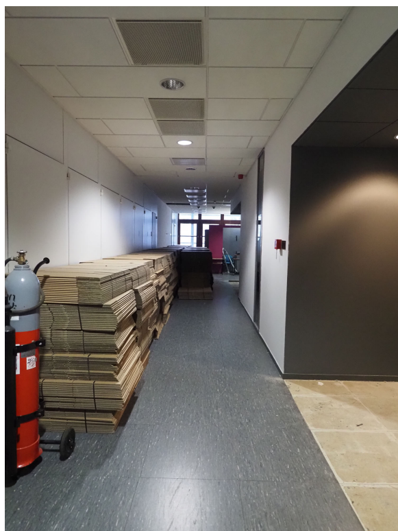
H16. I. emeleti közlekedőfolyosó
