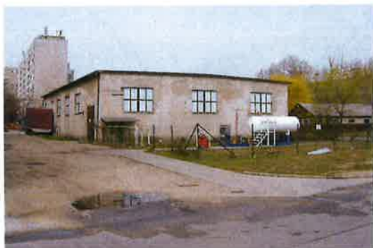
A korábbi „E” jelzésű raktár épület forrás: saját fotó
