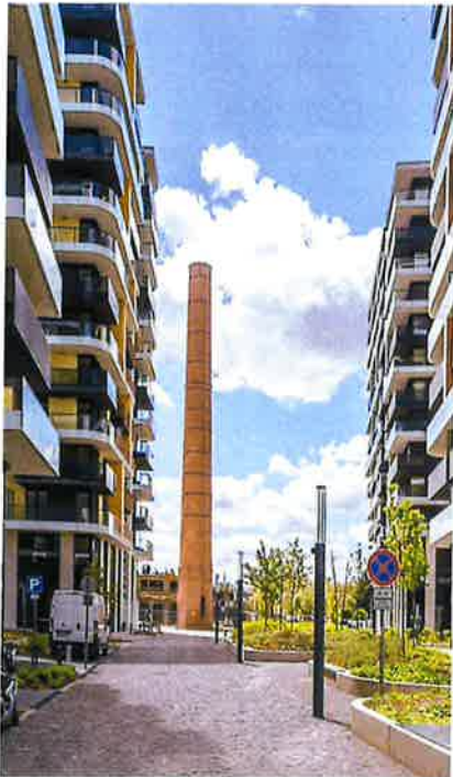
A Budai Promenádnak már megvalósult része a megőrzött, ipari múltat emlékeztető kéménnyel a Waterfront City területén forrás: saját fotó
