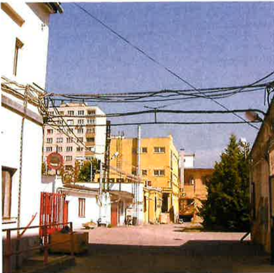
A korábbi trafóház és villanyszerelő műhely (bal oldalt az üdítőital üzem) forrás: saját fotó
