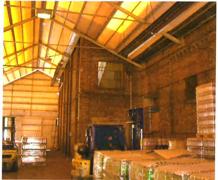
A korábban az épületek között elhelyezkedő fedett raktár forrás: saját fotó
